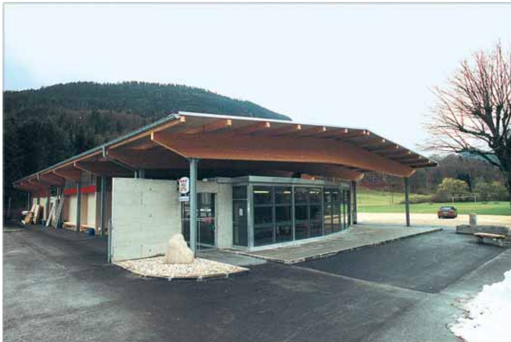
Bâtiment de service
