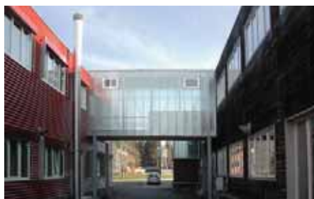
Passerelle façade sud-ouest
