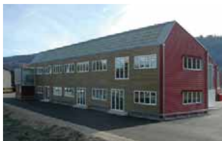
Façade long pan nord
