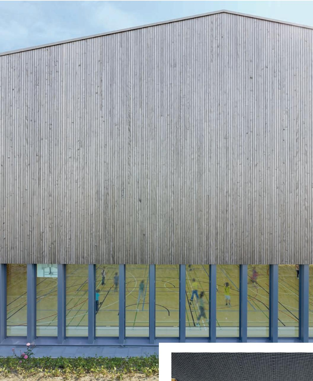
plus de 30 m, et de panneaux préfabriqués. Le revêtement extérieur a subi un traitement qui permet d'uniformiser son vieillissement. En toiture, un réseau de coupoles assure une lumière zénithale. L'un des pans a été prolongé en casquette de manière à pouvoir ouvrir la cafétéria sur l'extérieur en été.
