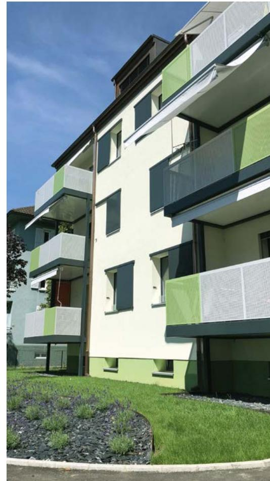
**RÉALISATION >** L'assainissement énergétique de l'enveloppe constituait l'une des priorités du Maître d'ouvrage. La construction d'origine « double mur, briques terre cuite » est habillée d'une isolation périphérique compacte de 18 centimètres et d'un crépi minéral. L'agrandissement des balcons a été réalisé par sciage des existants et la pose d'une structure porteuse indépendante.
