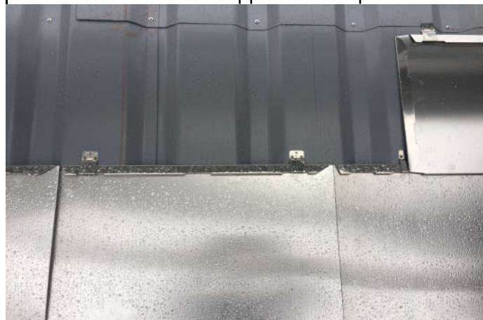
| Pose des écailles sur support de tôle profilée
